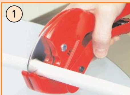
Трубу режут специальными ножницами
