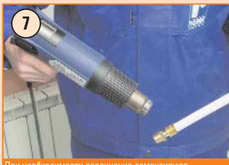
При необходимости соединение демонтируют с помощью строительного фена
