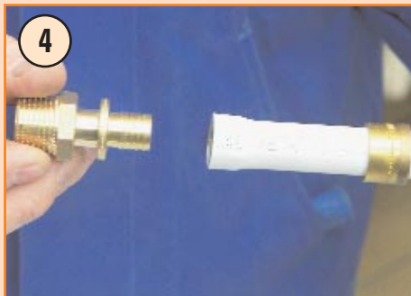
Затем фитинг вставляют в трубу
