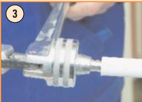
...и расширяют трубу калибровочным инструментом
